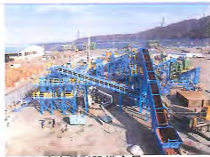
破碎選別設備全景
