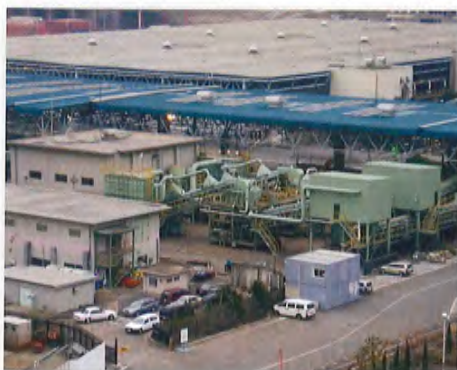
粗大ごみ破碎処理施設
