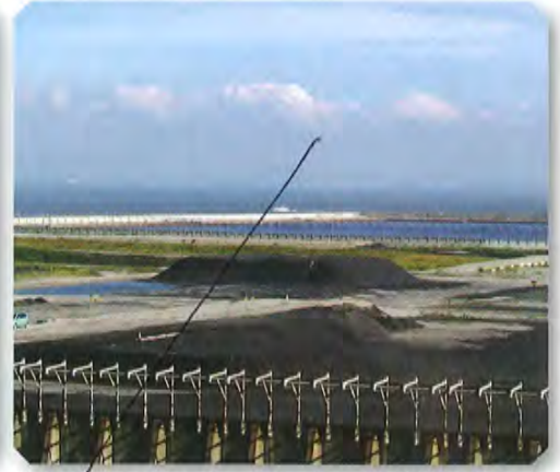
(将来イメージ) これからさらに埋め立てられていく新海面処分場に熔融スラグが仮置きされている状態
