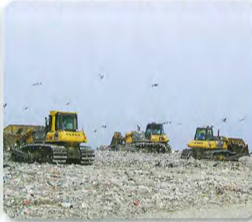
(現在) 不燃ごみなどが中間処理(破碎等)されて埋め立てられている状態
