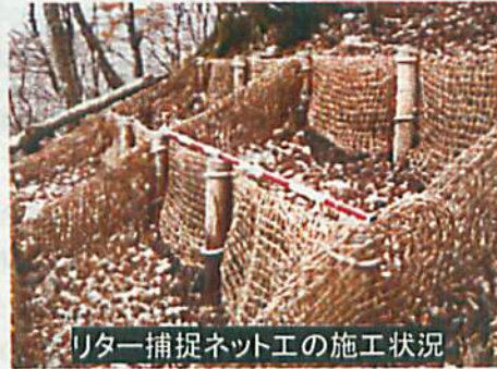
木製筋工(竹繊維ネット)の施工状況
