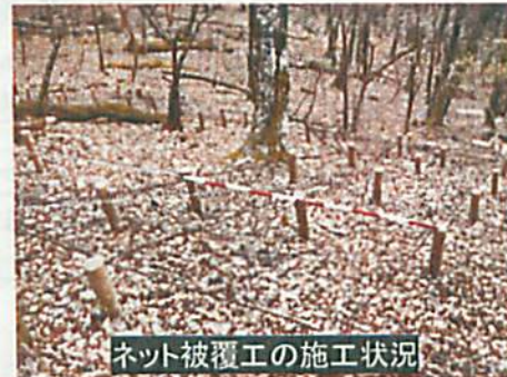
リター捕捉ネット工の施工状況
